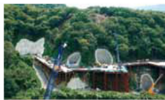
阪和自動車道・京奈和自動車道 和歌山ジャンクション(仮称)建設予定地
