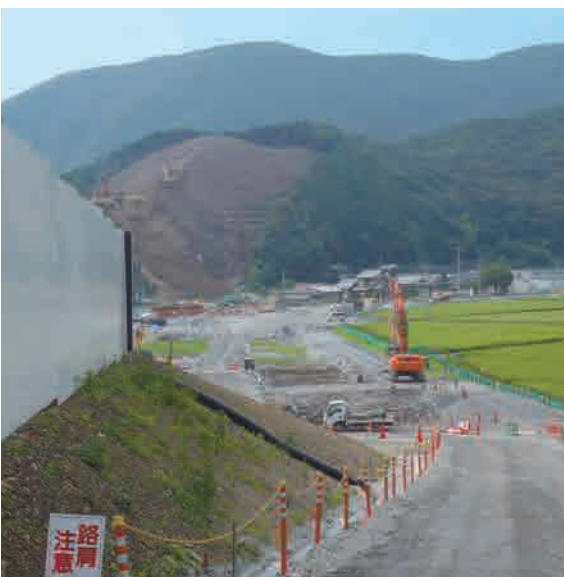
近畿自動車道紀勢線 すさみ西インターチェンジ(仮称)建設予定地
