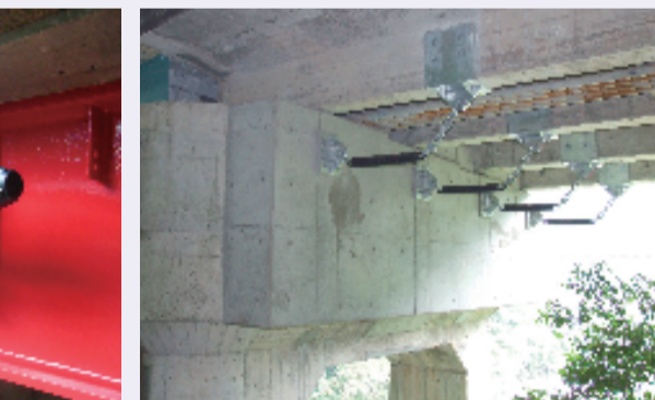
橋梁耐震化の施工例
