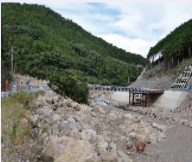
国道311号滝尻地区 復旧状況
