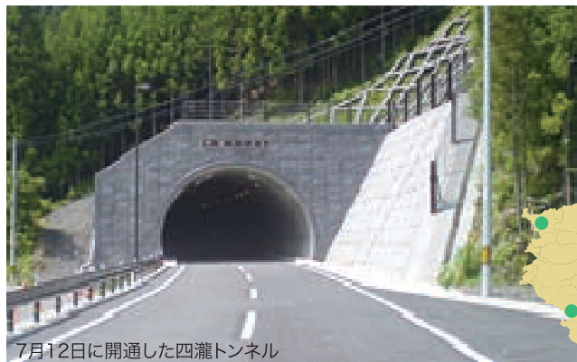
7月12日に開通した四瀬トンネル
