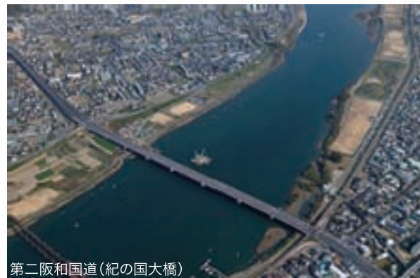
第二阪和国道(紀の国大橋)
