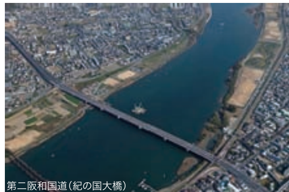
第二阪和国道(紀の国大橋)
