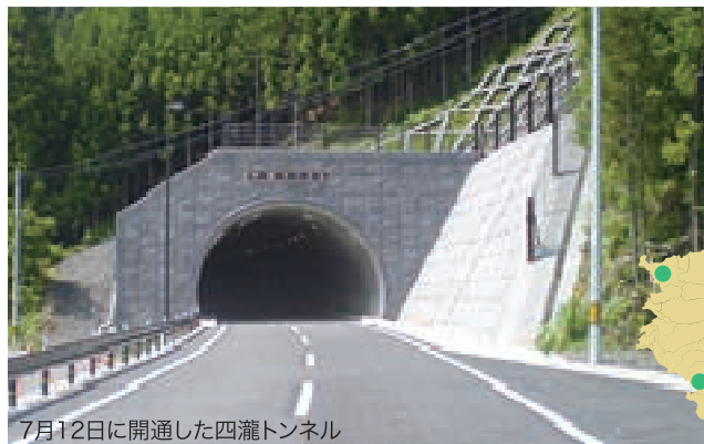
7月12日に開通した四瀬トンネル
