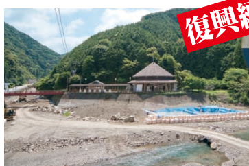
復旧工事が進む滝尻、熊野古道館付近。
