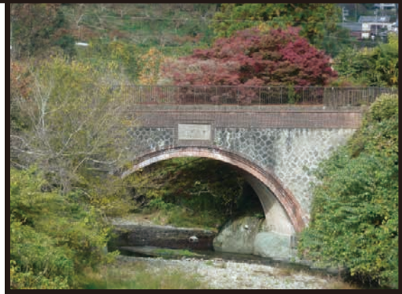
現在の龍之渡井(たつのとい)。建築された当初は木製であったが、大正8年に近代化され、レンガ・石張り造りに改修され今に至る。現在でも小田井用水路は約600haもの水田に水を供給し続けている。吉宗はこれらの技術を開東平野の開発にも導入し、「紀州流」として、その後の土木技術が受け継がれているという。紀州人の技術力の高さもまた、世界に誇るべきモノである。
