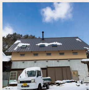
母屋と並ぶ納屋を再利用して、2階に住居に改装中。
