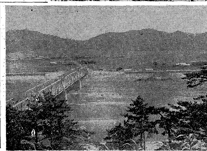
一面を見る影もなく荒れ果てた当時の有田川下流（有田市保田附近）の惨状【写真上】と現在の状況【写真左】川幅を広げて堤防を補強し、耕地は整理され、保田大橋はやや上流に架けかえられて面目を一新している。
