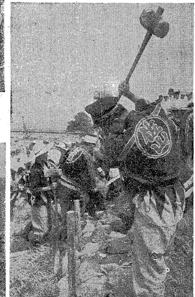
堤防の裏側へ水が噴き出しているようなとき、噴出口を中心にして土俵を積み上げ、水をためて水圧により漏水の勢を弱めるのがこの月輪工。土俵と土俵の間には土を詰め、充分踏み固めて水を漏らさないことが大切。
