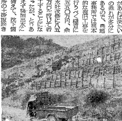
があれは決り、の恐れが多分にあり、農地事務所では根本的な復旧工事を行うべく、樋管に五五〇万円、余水吐改修に八五〇万円を投じて着工することになったが、この間に大雨が降り、樋管の土砂除去作業を開始した。この工事が完了すれば、従来の木の組合せの樋管がコンクリート管(内径四〇〇呎)となり、また立木をよめて樋管とする。
