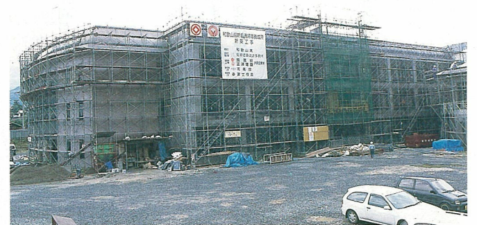
建設が進む県立高等看護学院（那賀町）
