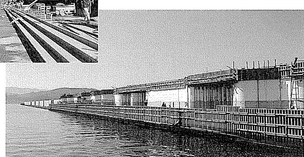
端部分では、全長九百二十メートルという日本初の親水性防波堤(ダブルデッキ型)の建設が着々と進められています。
