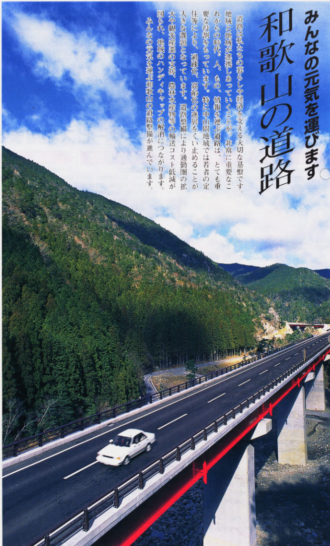
国道311号（中辺路町）
