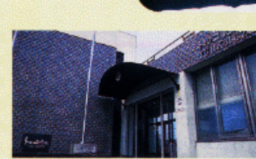
トルコ記念館・日米修交記念館周辺整備（串本町）平成8年度 国際交流施設の機能充実・駐車場整備
