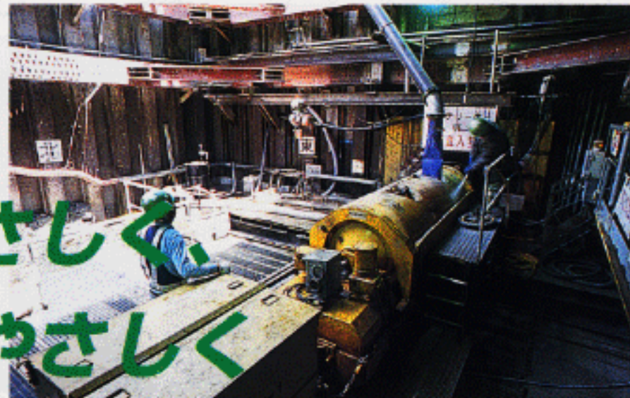
中央汚水幹線管きょう工事
