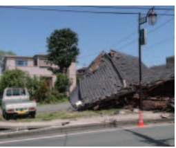
熊本地震で倒壊を免れた 家屋(左)と倒壊した家屋(右)
