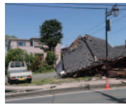
熊本地震で倒壊を免れた家屋(左)と倒壊した家屋(右)
