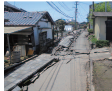
熊本地震で倒壊したブロック塀
