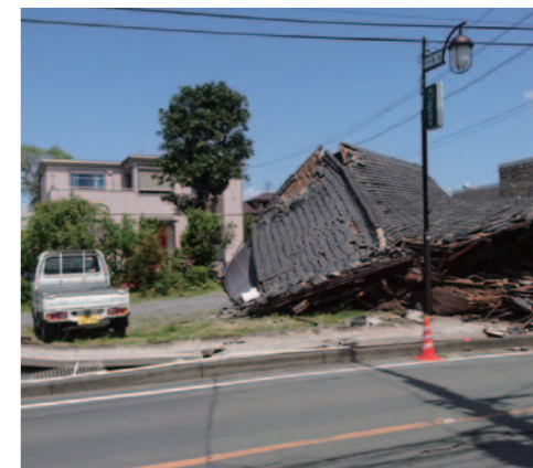
熊本地震で倒壊を免れた家屋と倒壊した家屋
