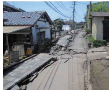
熊本地震で倒壊したブロック塀
