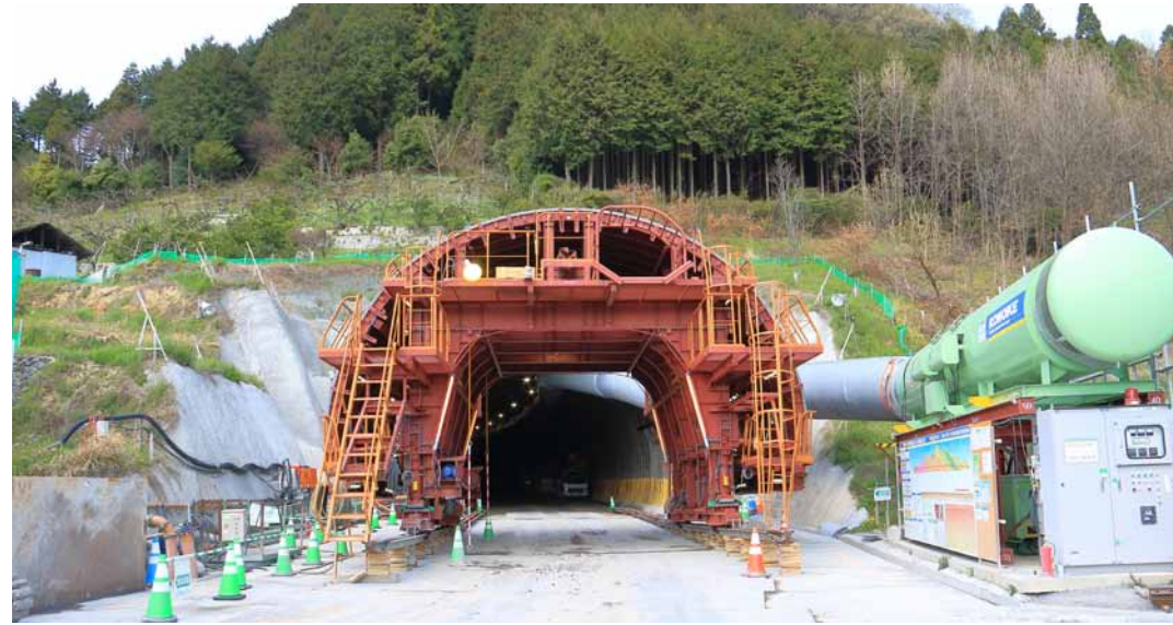
府県間道路 国道371号新紀見トンネル(橋本市)
