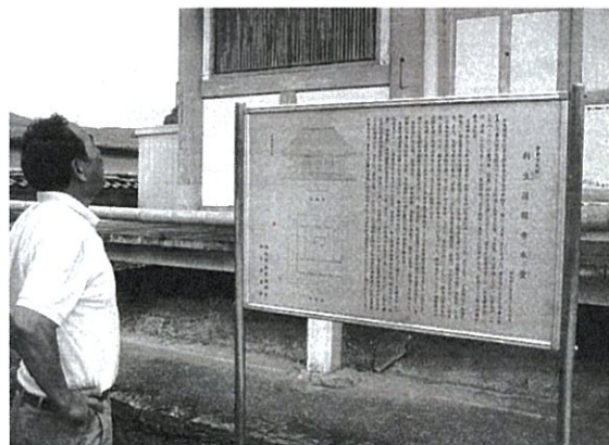
建物の屋根に歪みがないか、柱に腐り等がないか確認しています
