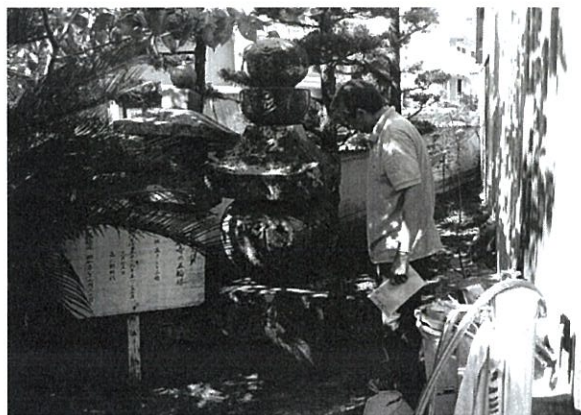
石造物の表面に劣化やひび割れ、ズレ等が無い確認しています
