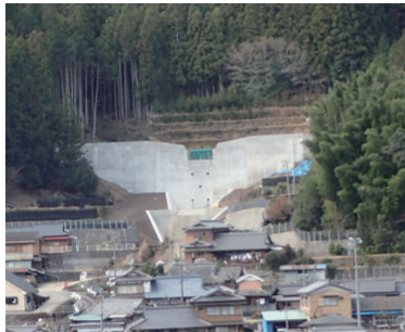
砂防ダム(日高川町皆瀬地内)
