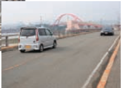
紀の川河口大橋
