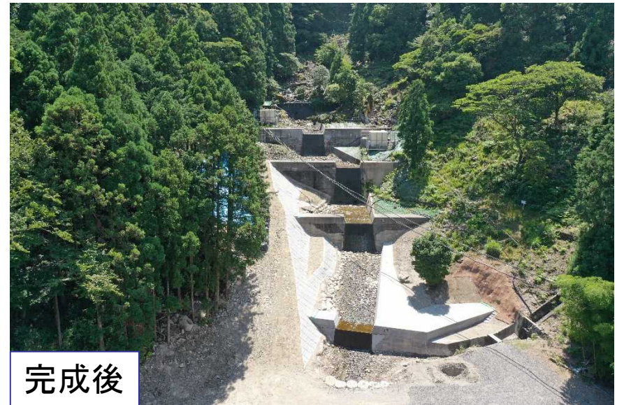
溪間工により復旧
