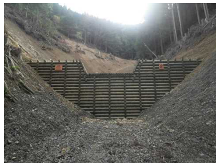
溪間工事の例
