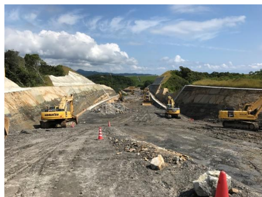
▲ 仮称鴨居高架橋～町道櫛ヶ峯権現谷線
