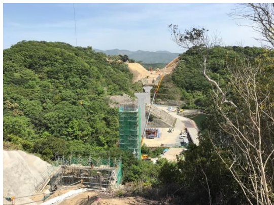
▲ 仮称鴨居高架橋
