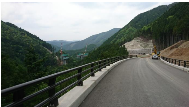
▲ 仮称 宮の谷4号橋 付近
