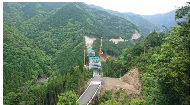
▲ 仮称 宮の谷5号橋
