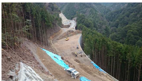
▲ 仮称 宮の谷5号橋
