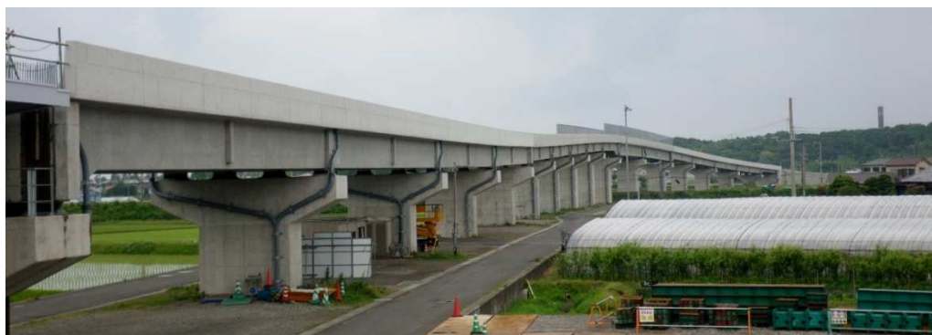
▲ 南白浜高架橋
