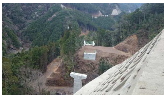
▲ 仮称 宮の谷6号橋
