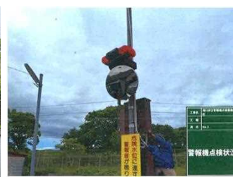
竜川水位警報機点検
