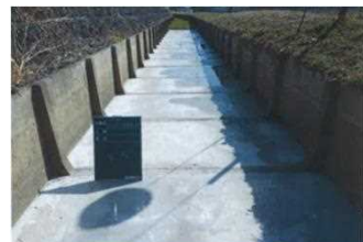
底張コンクリート
