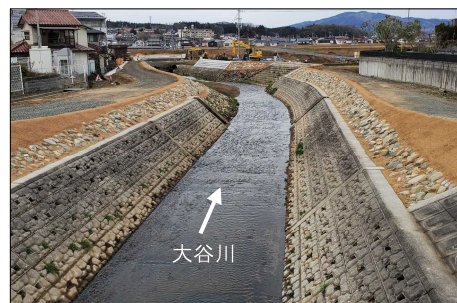
広島県による支川の改修
