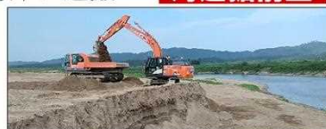
河道掘削・積込(場内運搬)の状況 (R4.8.23 撮影)
