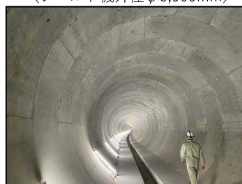
雨水貯留管内部 (仕上がり内径φ5,250mm)
