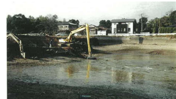
＜ため池の浚渫工事＞
