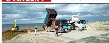
養浜材の荷下・投入状況 (R4.8.18 撮影)
