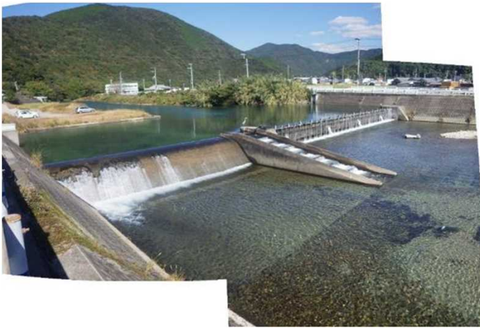
病院前頭首工
