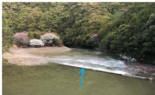
周参見川浚渫状況(原井堰付近)
