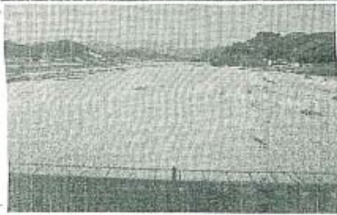
▲ 瀬切れの富田川。2月20日撮影。富田川は、2月20日現在、生馬橋から上流の区間で河川水が伏流し、地表水がかわることがあり、アユの遡上・降下への影響が懸念されているが、地表水の枯渇と漁獲高への影響については把握されていない。
