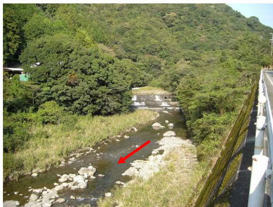
二川橋上流の堰堤
