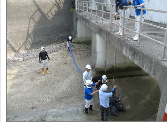
【ポンプを設置する訓練】
