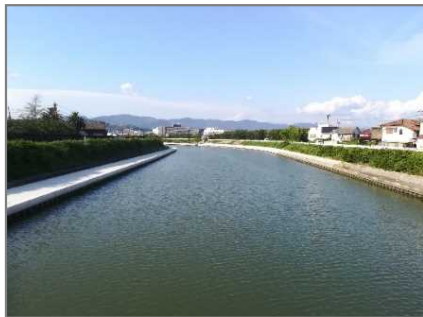
【西川 大川橋付近】
