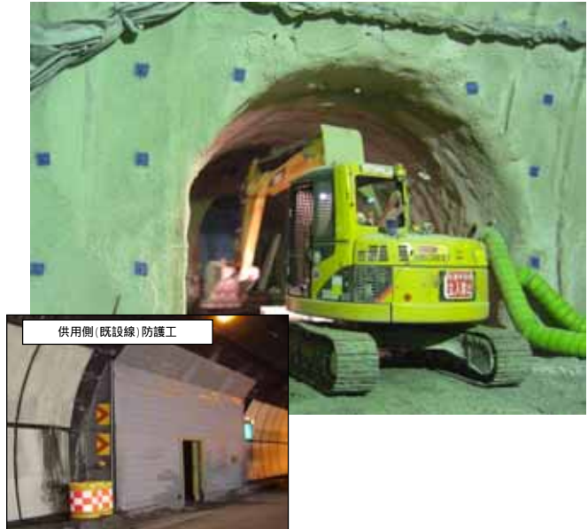
避難連絡坑拡幅状況
