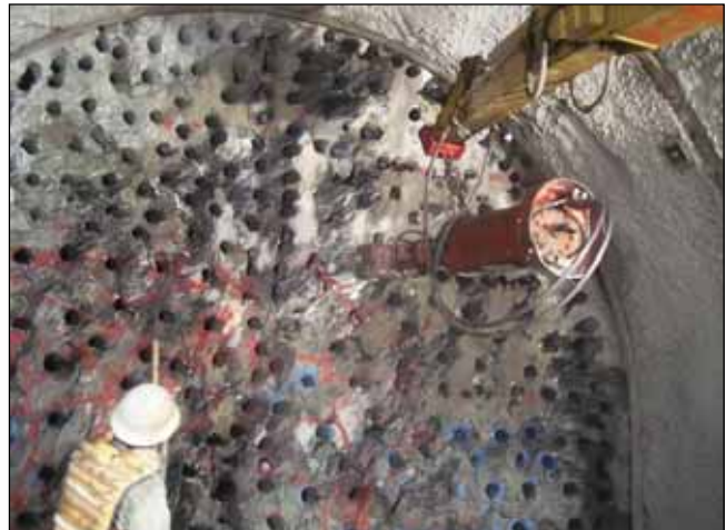
削岩工法による避難連絡坑新設工事
