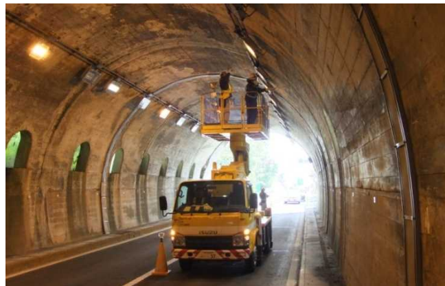
写真-解 6.1 近接目視作業状況
