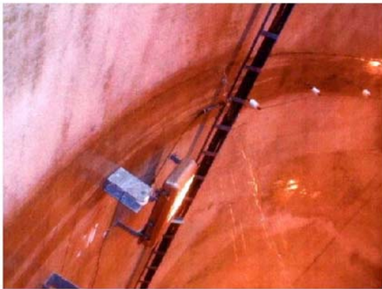
付写真-1.7 漏水（噴出）している例
