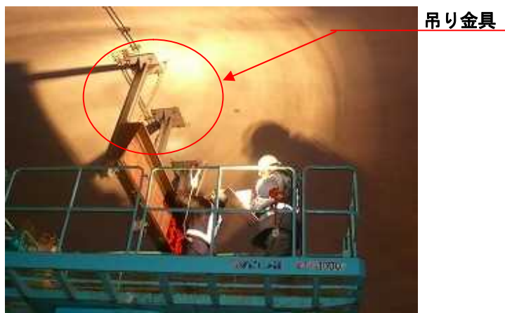
写真-解 6.3 触診作業状況
