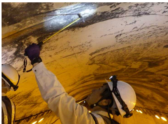
(a) トンネル本体工
