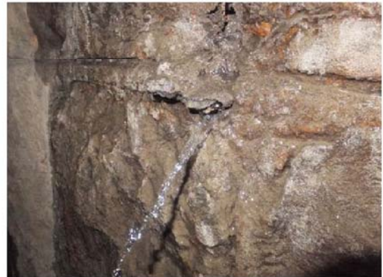
付写真-1.7 漏水（噴出）している例
