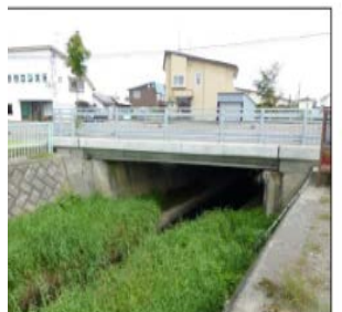
※通常地覆水切りが桁下まで打ち下ろされているため、横桁位置が確認できない。
