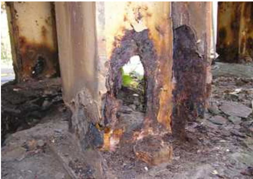
腐食片を取り除いた状態の例（下部）
