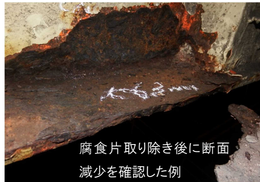
腐食片を取り除いた状態の例（主桁）
