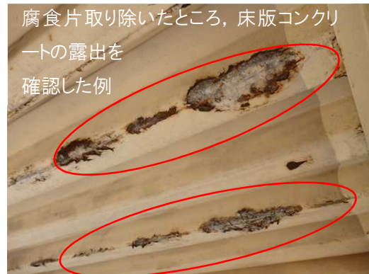
腐食片を取り除いた状態の例（床版）
