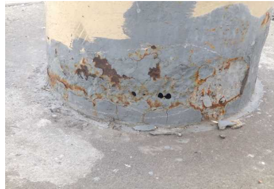
腐食片を取り除いた状態の例（下部）
