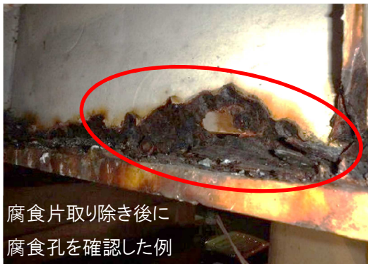
腐食片を取り除いた状態の例（主桁）
