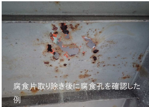
腐食片を取り除いた状態の例（床版）
