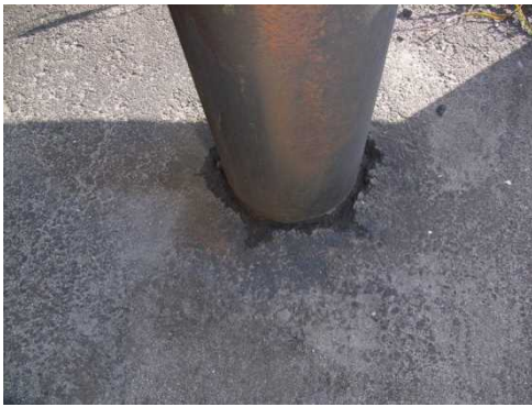
腐食、路面付近での滞水
