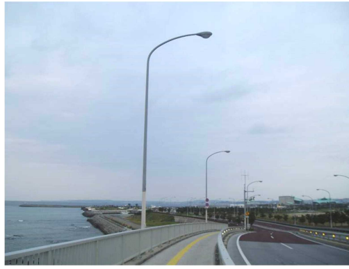
海岸付近に設置
