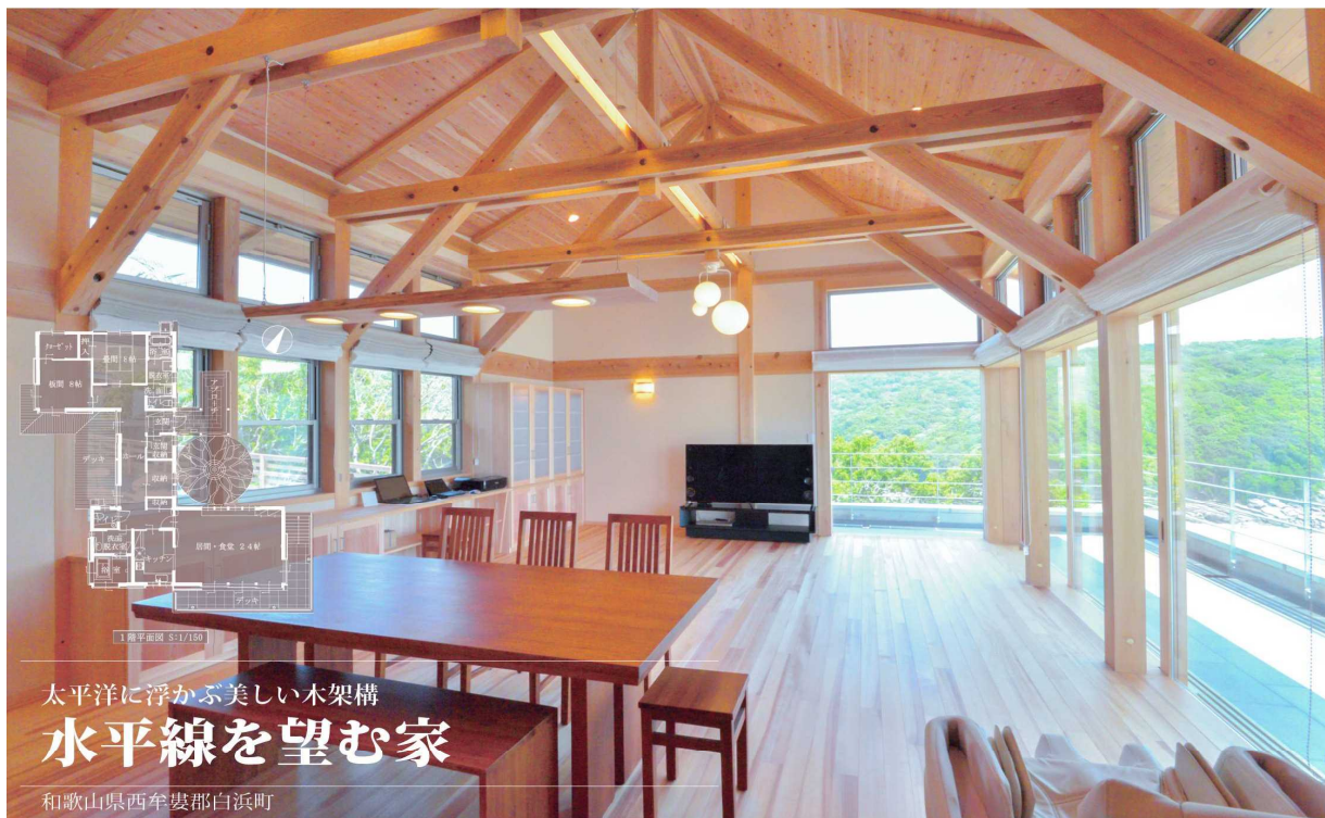
■大空間を可能にした複雑な木架構。設計段階からの入念な検討・現場での職人との対話を経て、実現した。 ■リビングの木製大開口。ベランダからはこの地方独特の岩場と水平線を望む。
