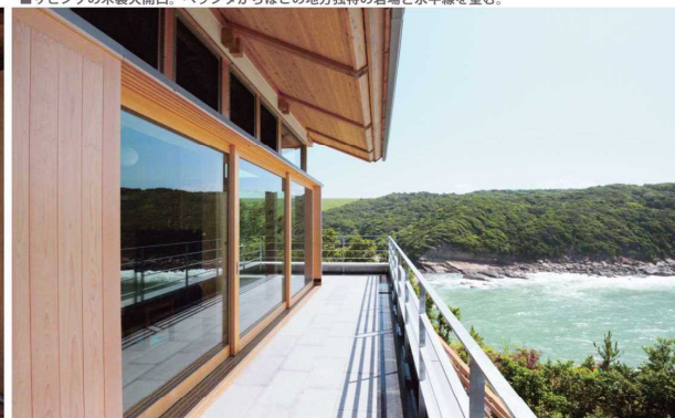
■大空間を可能にした複雑な木架構。設計段階からの入念な検討・現場での職人との対話を経て、実現した。 ■リビングの木製大開口。ベランダからはこの地方独特の岩場と水平線を望む。
