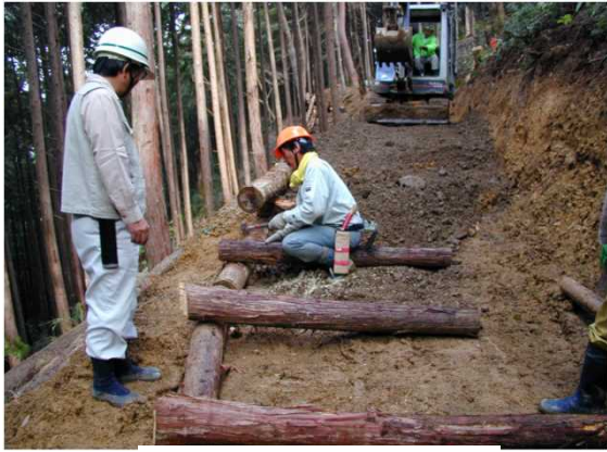
作業道作設講習
