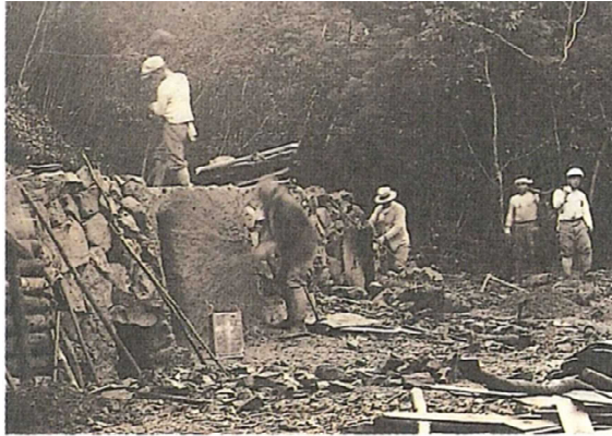
木炭に関する試験 (築窯作業)
