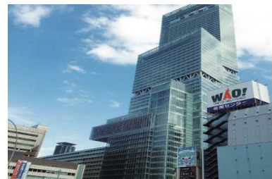
高層ビル鉄骨
