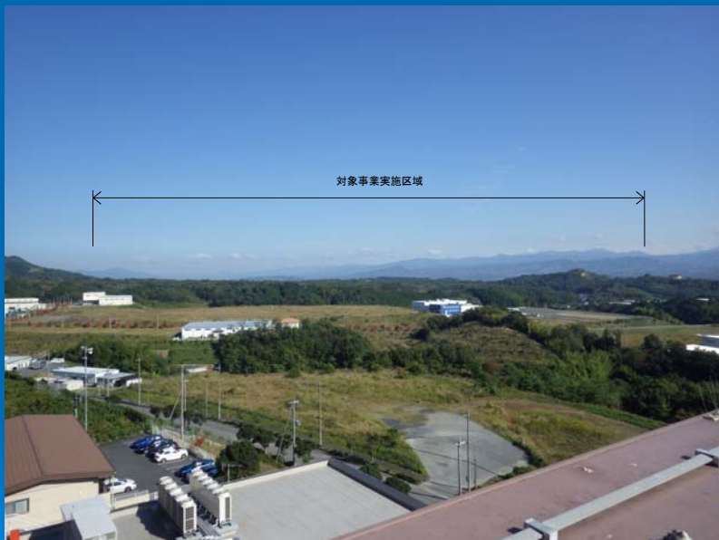
橋本市民病院(現況)
