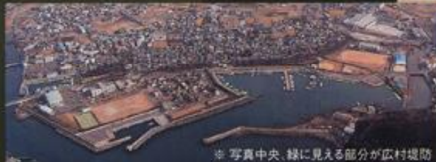
※ 写真中央、線に見える部分が広村堤防
