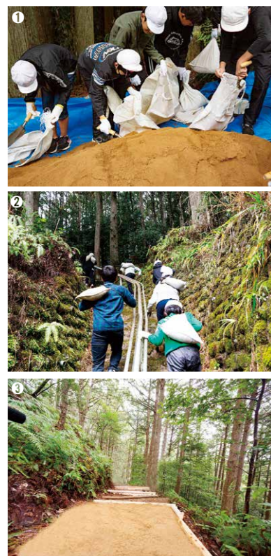
①土嚢に込める真砂土はあえて他所のものを使用する。そうすることで地層ができ、現在の様子を数十年後数百年後に伝えることができるという。 ②修復箇所に必要な土を分担して運ぶ。この日は急な階段を何往復もして、1人あたり約5kgもある土嚢を担いで上った子ども達。③足で踏み固めることで、より強固なものになり、道が再生される。
