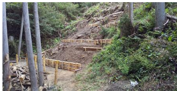
復旧後の状況
