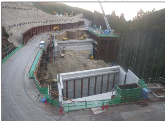
近畿自動車道紀勢線(すさみ町) (株)尾花組 橋台 2基、仮栈橋 外
