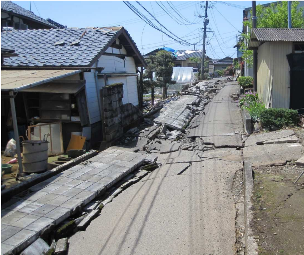
倒壊したブロック塀
