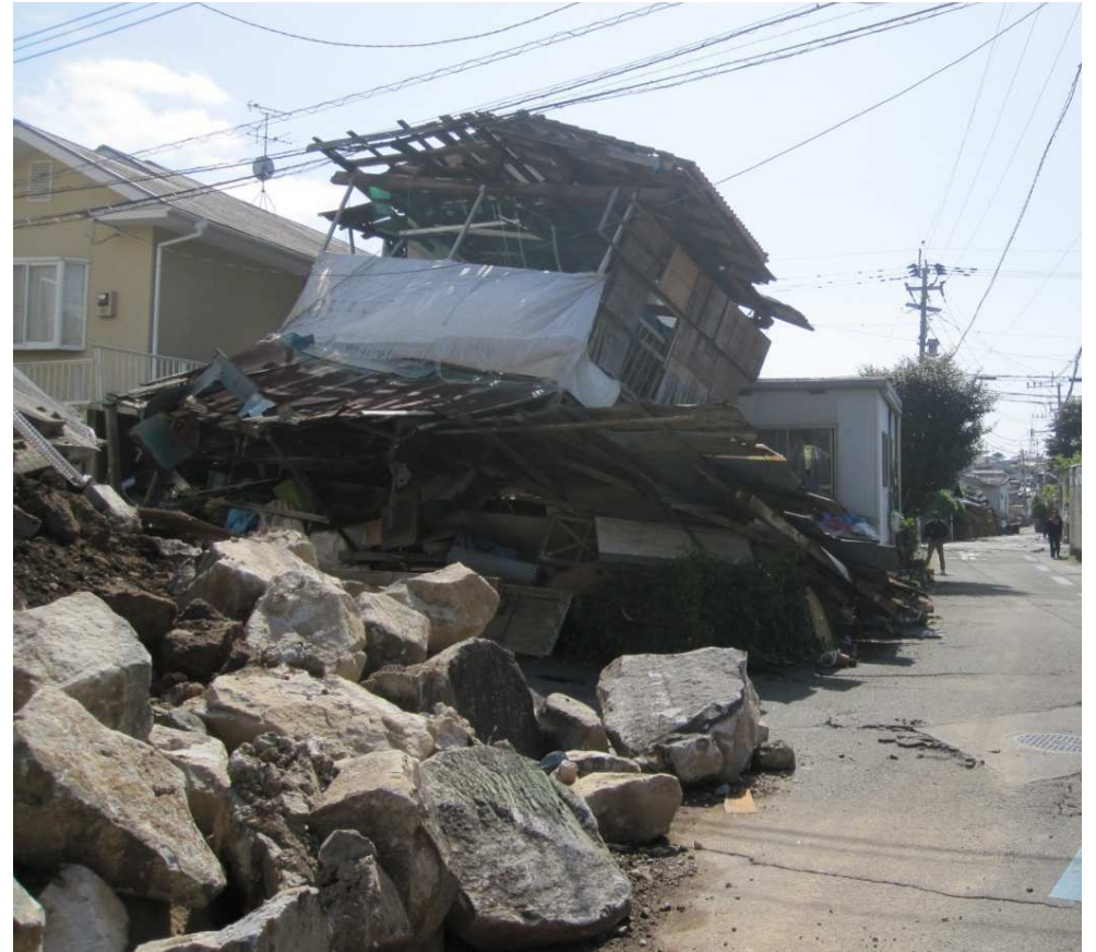
崩落した石垣と倒壊家屋
