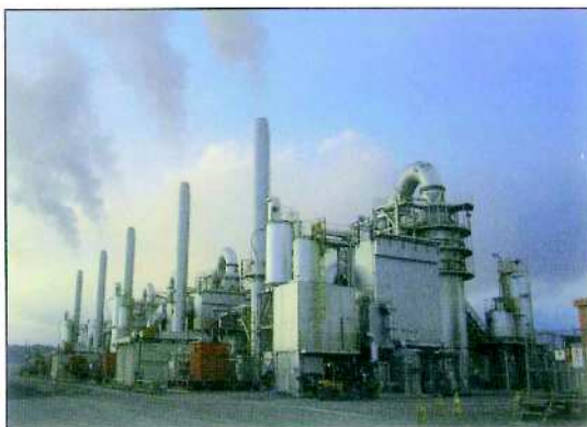
※仮設焼却施設 （東日本大震災：宮城県）
