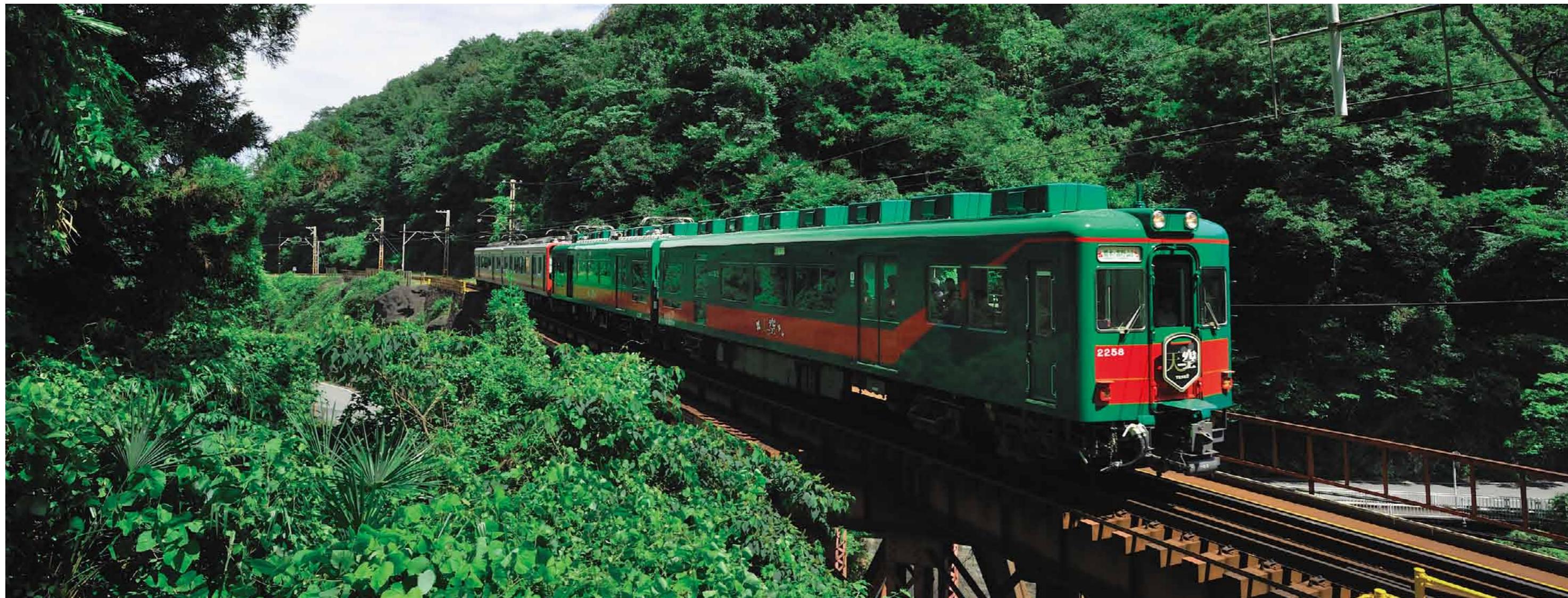
丹生川橋梁を駆け抜ける天空
