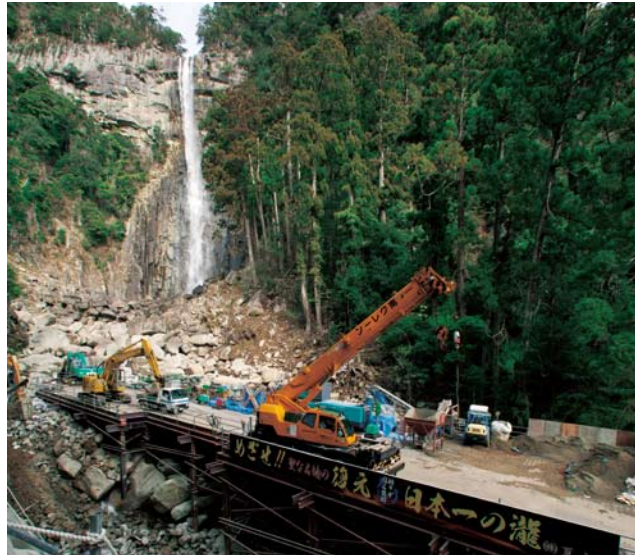
雨と濁流のため、滝壺周辺の崖は大木ごと激しくえぐられ、むきだしの足場になった地面が痛々しい。仮設の足場が組まれ、重機やトラックが巨大な岩の撤去作業を続けている。
