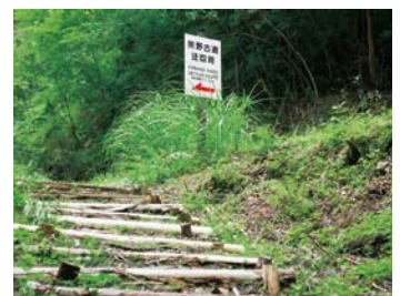
台風被害に伴い、新たに設けた迂回ルート。歩きやすいようヒノキで足場を組んでいる。
